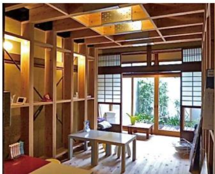
写真 - 耐震シェルター事例
