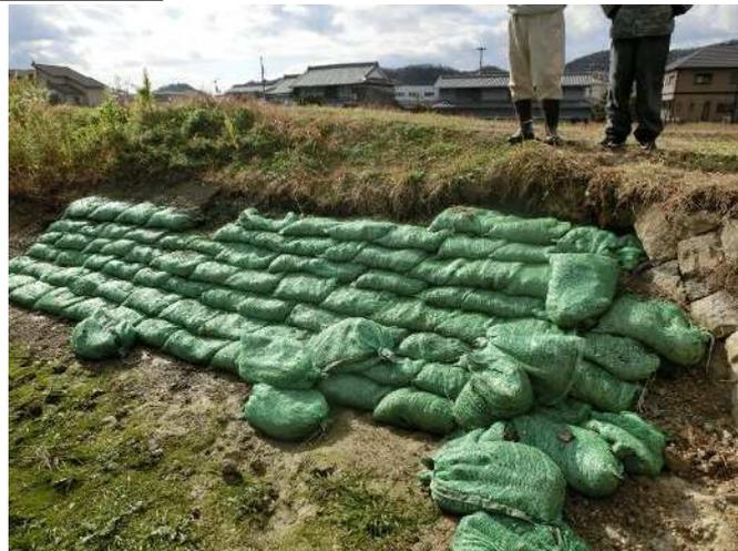
堤体上流法面に土のう設置
