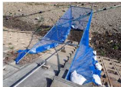
取水施設周りに防風ネットを設置
