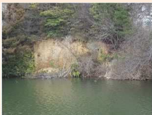
土砂崩壊のおそれ
