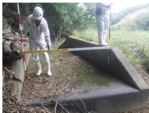
洪水吐断面の確認
