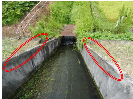
洪水吐周囲(堤体上流から)
