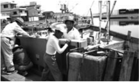
▲防潮扉を閉める住民（湊港）
