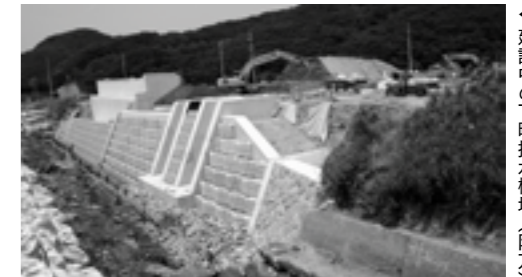
◀建設中の下町排水機場（阿万）
