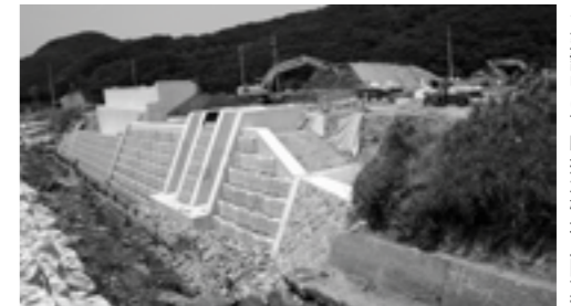
▶ 建設中の下町排水機場（阿万）
