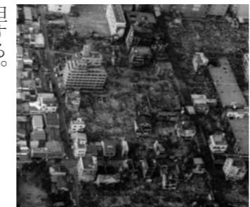
▲震災による火災で焼失した長田区の家屋
