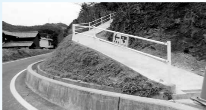
▲福良向谷に整備した避難路
