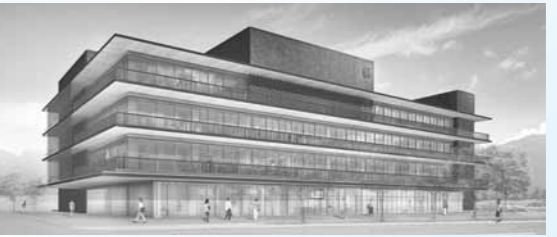
▲平成26年度の新庁舎開庁に目指し、平成25年度に建設工事に着手する
