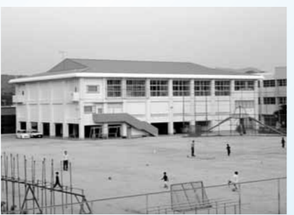
▲24年度に耐震補強工事を行った福良小学校屋内運動場
