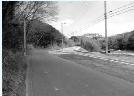
▲工事が進む市道津井伊加利線
