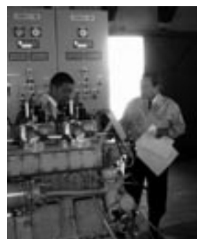
▲排水機場の視察
