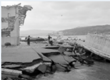
▲被災した護岸
