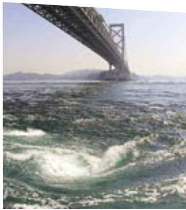
▲うず潮と大鳴門橋
