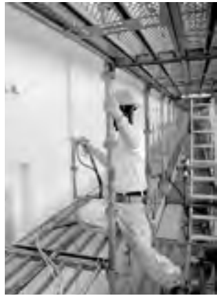
▲体育館大規模改造工事
