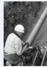
▲下水道管敷設工事
