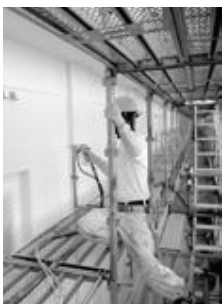
▲体育館大規模改修工事
