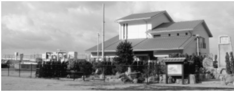
津井浄化センター
