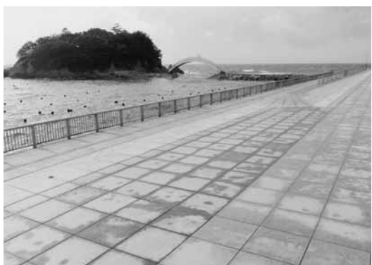
▲埋め立て地を確認(阿那賀・沼島の9か所)
