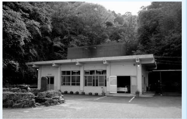
▲老朽化した火葬場
