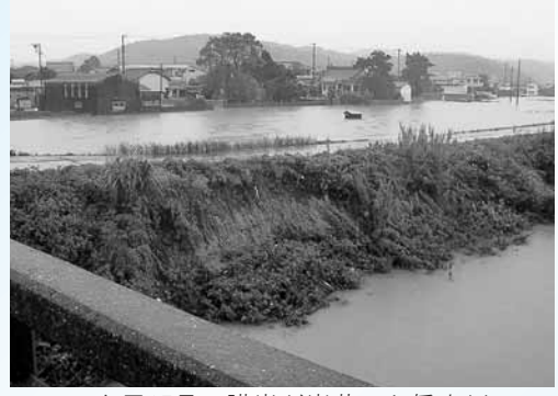
▲台風15号で護岸が崩落した倭文川
