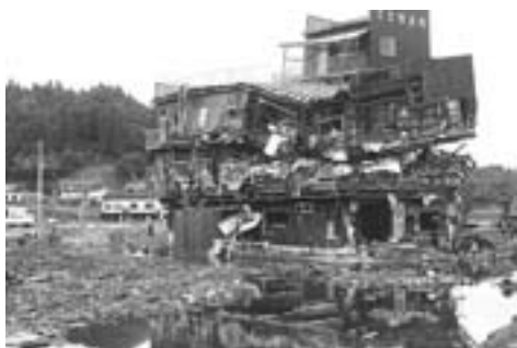
▲津波の被害を受けた旅館
