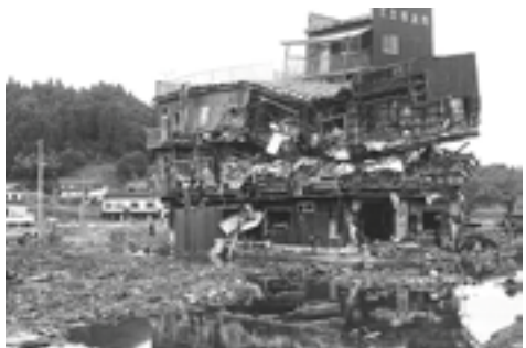
▲津波の被害を受けた旅館
