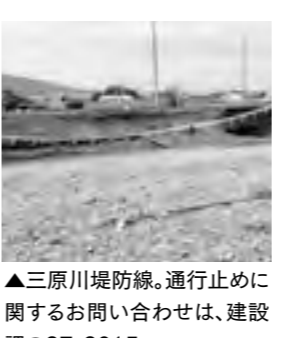
▲三原川堤防線。通行止めに関するお問い合わせは、建設課 ☎37-3015
