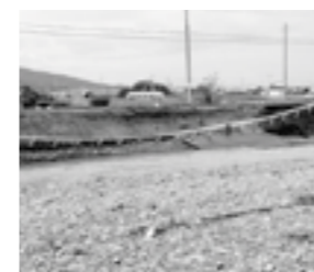
▲三原川堤防線。通行止めに 関するお問い合わせは、建設課 ☎37-3015
