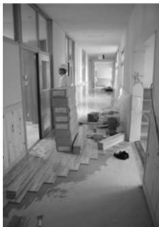
完成間近の1階廊下
