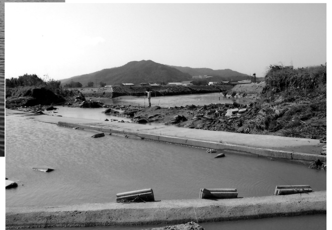
堤防が流失した大日川 (馬乗捨川との合流地点 榎列)
