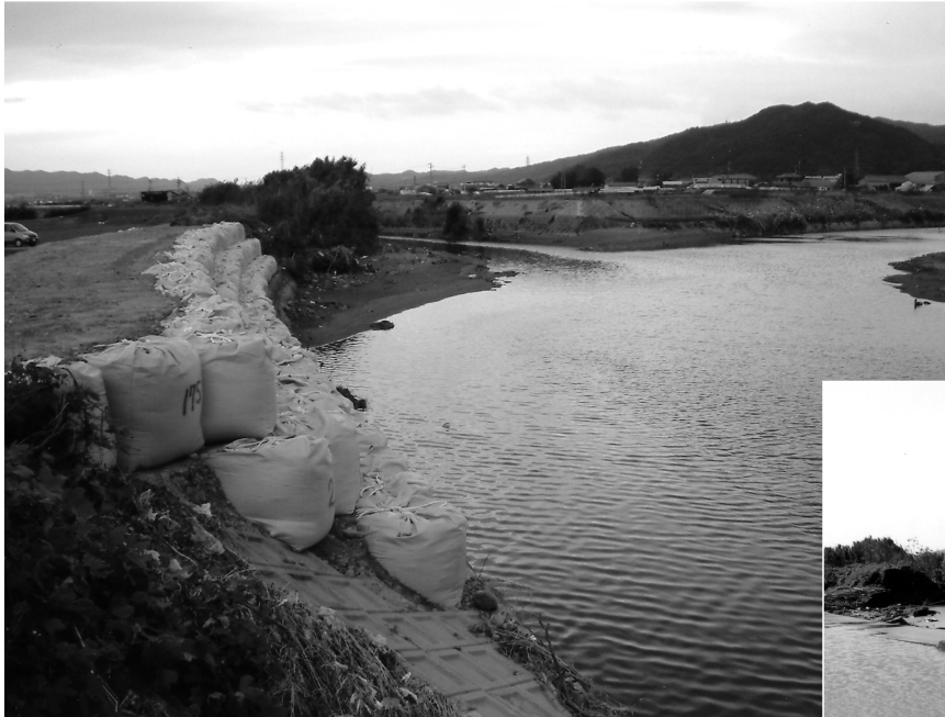
大型土のう250個で応急修理された堤防
