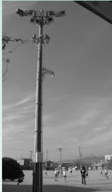
高さ12mの照明灯
