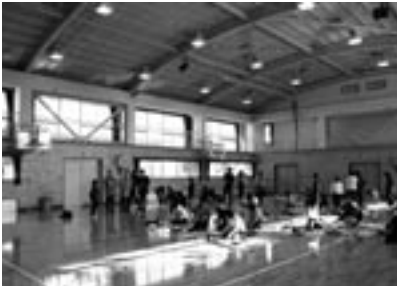
▲西淡志知小学校屋内運動場耐震補強及び大規模改修
