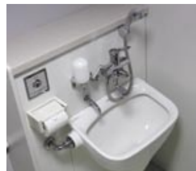
▲障害者用トイレ内に設置した洗浄場
