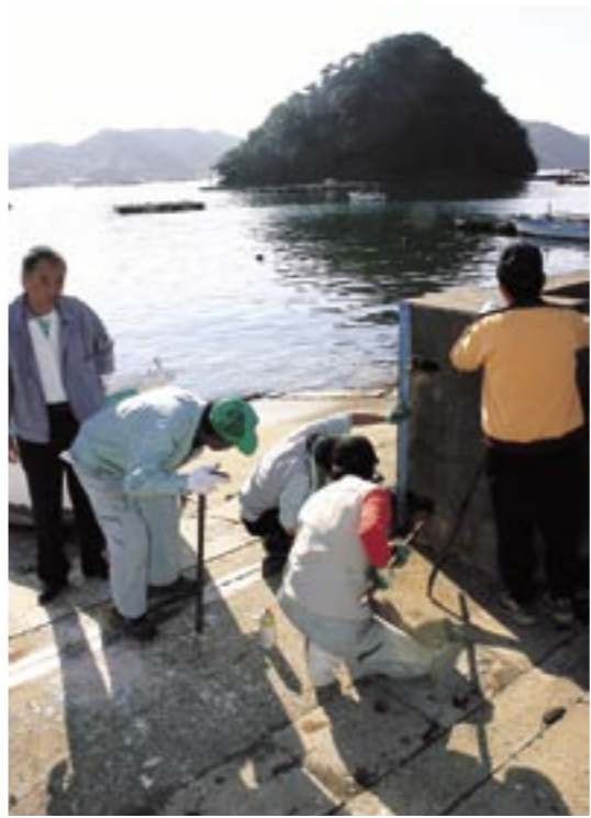
▲津波に備えて福良港周辺で水門を閉鎖
