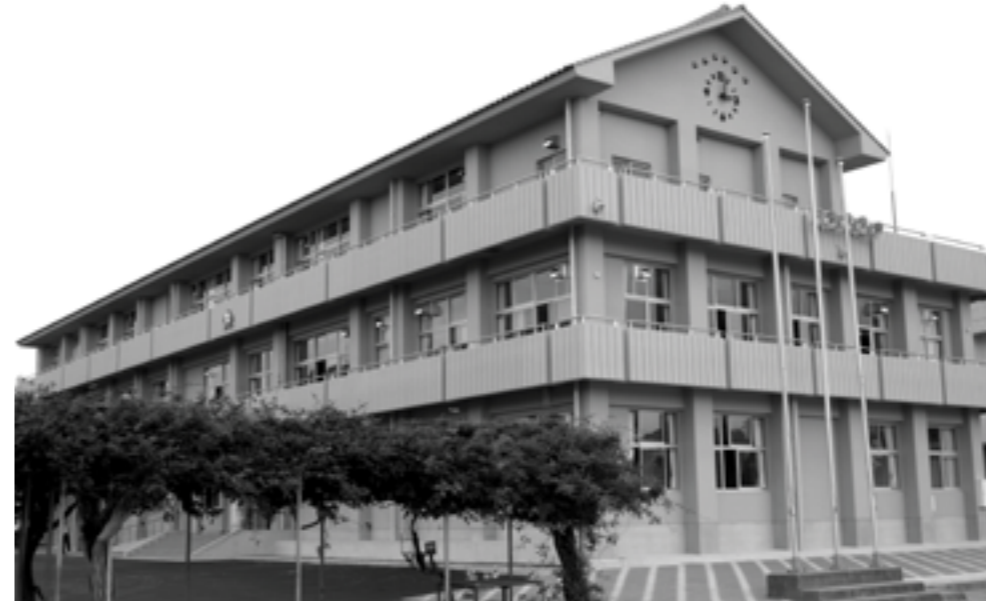
▲松帆小学校南校舎
