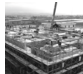
1階の型枠組立て(平成18年2月24日)
