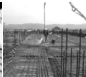
2階天井の鉄筋(平成18年4月19日)
