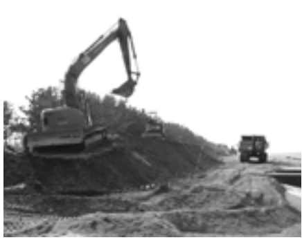
▲慶野松原での盛土工事
