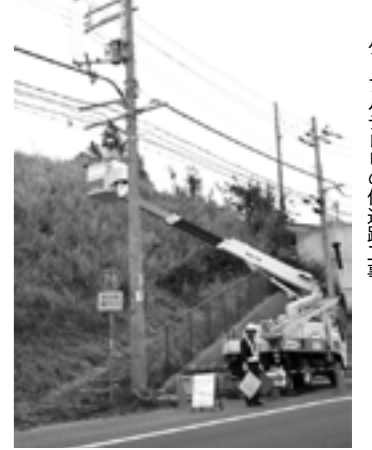
ケーブルテレビの伝送路工事
