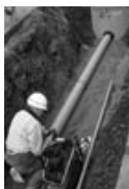
▲下水道管敷設工事
