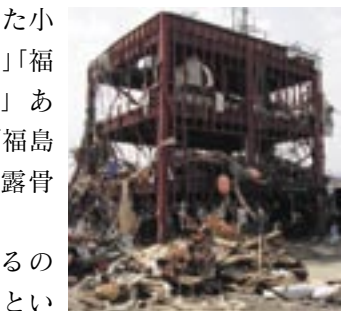
▲南三陸町の防災対策庁舎
