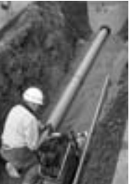
▲下水道管敷設工事
