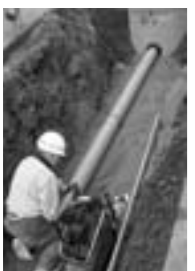
▲下水道管敷設工事
