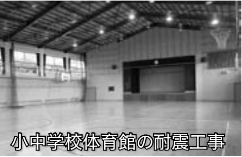
小中学校体育館の耐震工事 ▲教育費＝2億6,513万円、倭文・北阿万・灘小学校の体育館と沼島中学校の体育館を耐震改修しました(写真は、灘小学校体育館)
