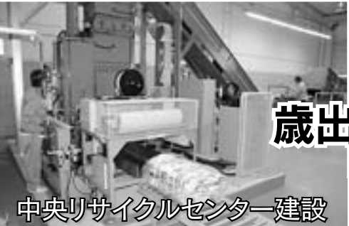
中央リサイクルセンター建設 ▲衛生費＝2億8,073万円、21年8月から不燃ゴミと資源ゴミの受け入れを開始しています
