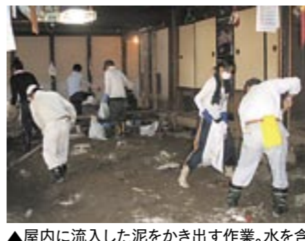
▲屋内に流入した泥をかき出す作業。水を含んだ粘り気のある土で作業は難航しました
