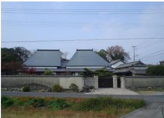
写真 - 菊川家住宅（兵庫県景観形成重要建築物）
