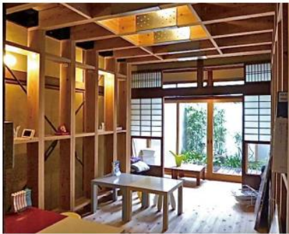
23 写真 - 耐震シェルター事例
