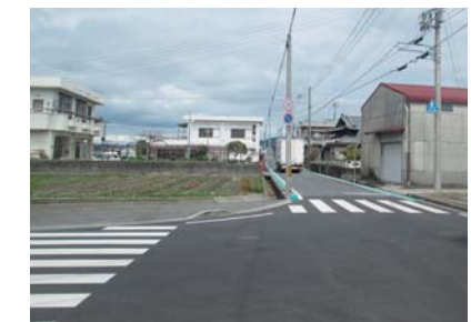
▲大榎列古津路線と古長田線のクラック
