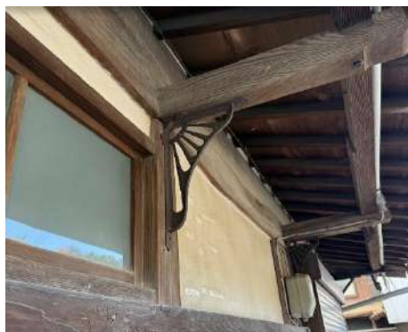
下屋を支える鋳物金物
