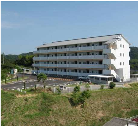
写真 - 市営住宅 しづおり第 2 団地
