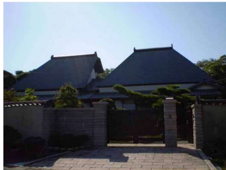
写真 - 菊川家住宅（兵庫県景観形成重要建築物）
