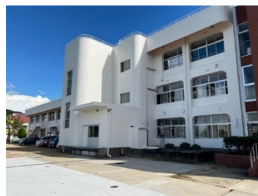
賀集小学校大規模改造工事
