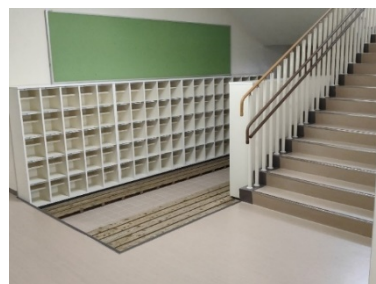
榎列小学校南校舎大規模改造工事
