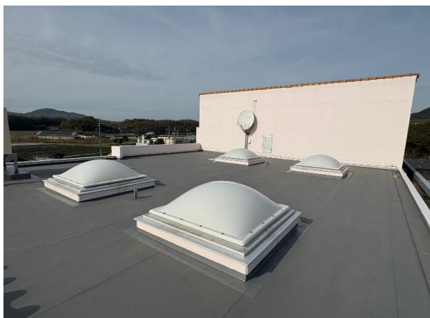
倭文小学校屋上屋根防水工事
