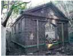
※行者ヶ嶽砲台のレンガ建物
