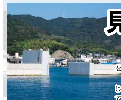
福良港湾口防波堤
