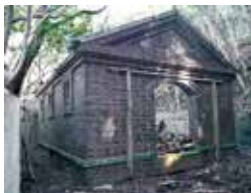
※行者ヶ嶽砲台のレンガ建物
