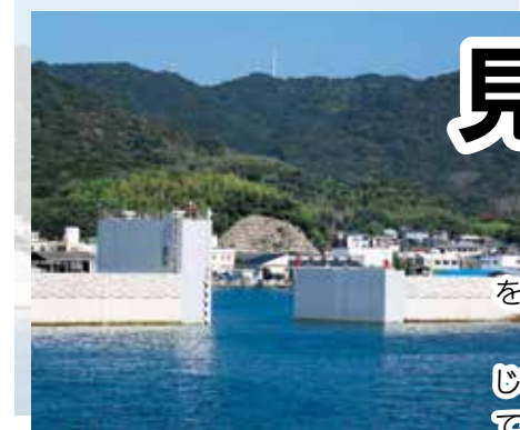
福良港湾口防波堤
