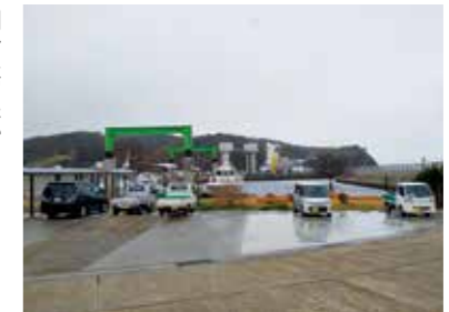
拡張された沼島ターミナルセンター駐車場
