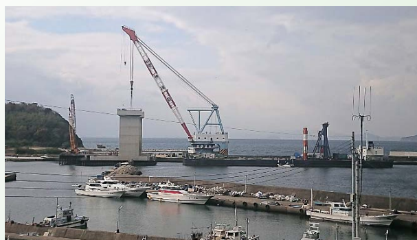
▲沼島水門工事
