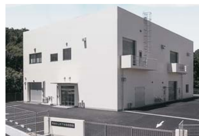
▲下水放流施設
