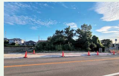
▲完了間近の歩道（王将付近）
