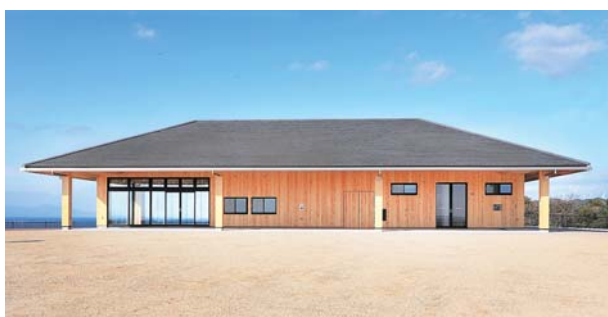
▲鳴門岬駐車場「うずまちテラス」
