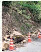
▲論鶴羽ダム公園 県と市で協議中の修繕箇所
