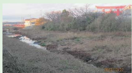
▲三原川の雑木状況、おのころ橋周辺
