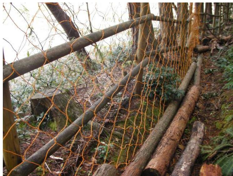
シカの飛び込みやすい斜面部分の金網柵に**ネット柵**でかさ上げをしている。
